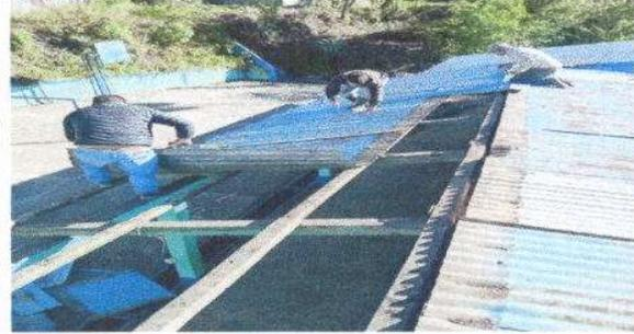
Foto 2: desmontando laminas de aulas 3 y 4
